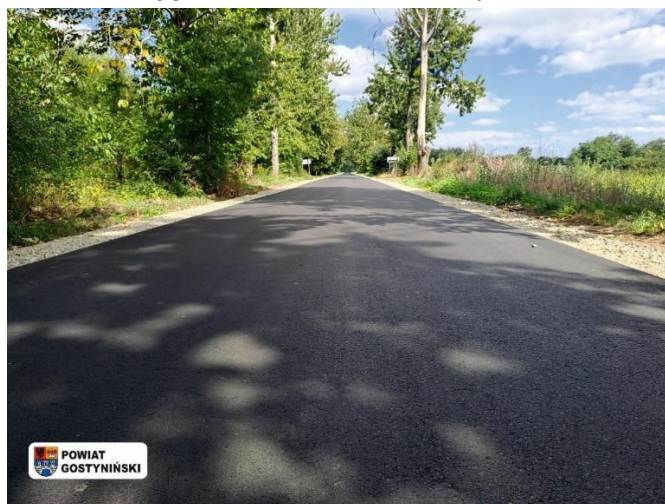
Droga powiatowa Sanniki-Jamno-Iłów.
